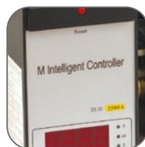
Микропроцессорный расцепитель с селективной программируемой защитой
