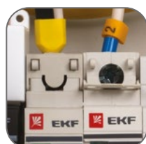
Имеет пломбировку вводного аппарата
