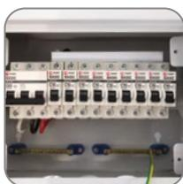
Коммутация групповых аппаратов выполнена трехрядной соединительной шиной
